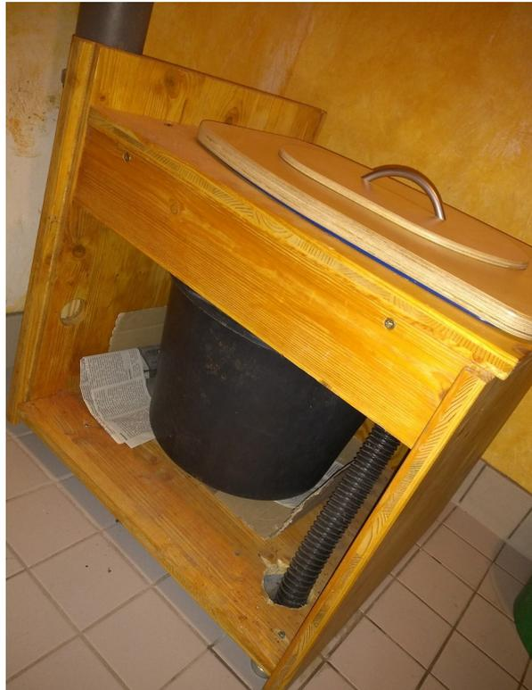
*Abbildung 22: Kompost-Trenntoilette in der Wönnichstr. 103. Separate Urinabführung vorne, trockene Sammlung der Fäzes im Eimer hinten. Abluftabführung über Rohr zum Dach. Quelle: eigenes Foto*
