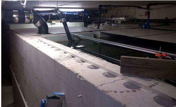
*Abbildung 21: gemauerter Tank zum Speichern des Niederschlagswassers im Keller von LaVidaVerde, Quelle: eigenes Foto*
