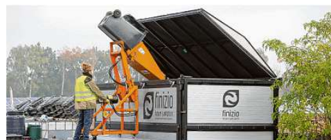
Oben links: Am Messingwerkhafen Eberswalde wird eine Öko-Toilette der Firma Finizio aufgestellt. Drei Stück davon stehen in der Barnimer Kreisstadt. Links: Eine Tonne mit Feststoffen aus den Toiletten wird in den CSC-Container gekippt – die erste Stufe des Kompostierungsprozesses. Rechts: Jan-Ole Boness (l.) begleitet den Versuch wissenschaftlich und spricht auf dem Feld bei Zerpenschleuse mit Thomas Wrase von der Sag-Schorfheide. Unten: Johannes Hölzel von der Firma Finizio am Kompostwender, der die Miete anfangs täglich umschichtet.
